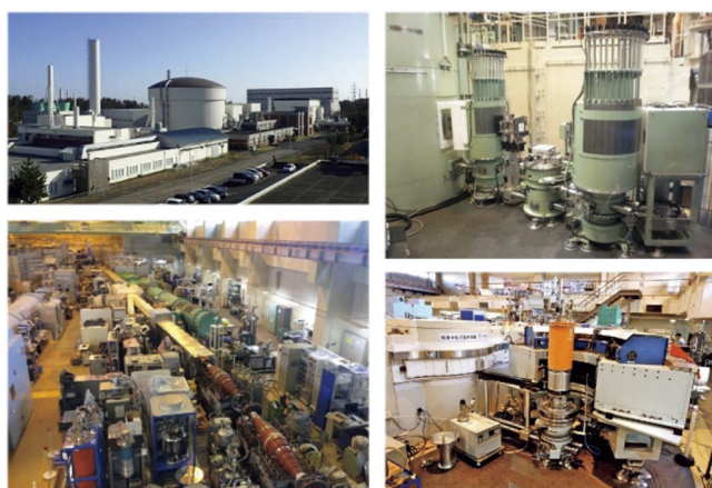
図1 研究用定常中性子源 JRR-3 の(左上)全景と(左下)ビームホール内の様子、および、(右上)金属材料研究所が管理運営する中性子測定装置。(オンラインカラー)
