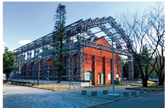
図5 修復中の資料館 (5) .
