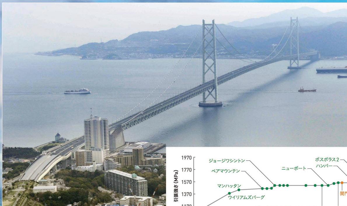
(図2) 明石海峡大橋。
