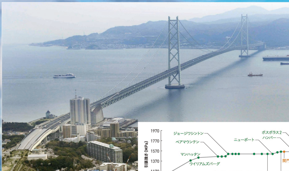
(図2) 明石海峡大橋。
