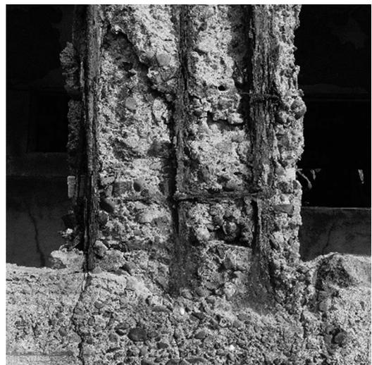
図4 鉄筋の腐食により劣化したコンクリート柱。コンクリートが剥がれ腐食した鉄筋がむき出しになっている(2016年長崎県端島(通称、軍艦島)にて撮影)。
