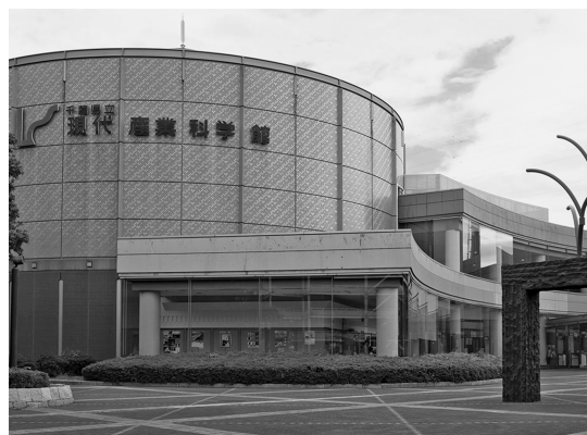
図1 千葉県立現代産業科学館 入口付近外観。
