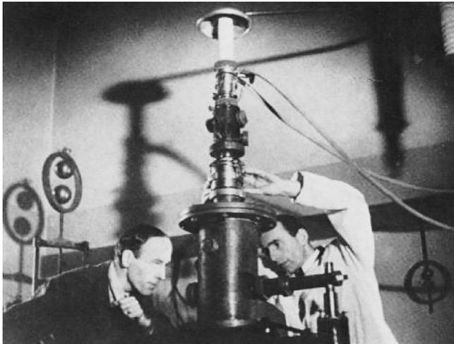
図1 電子顕微鏡試作機と Knoll と Ruska<sup>(4)</sup>.
