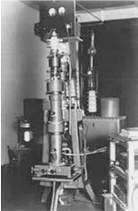
図2 日本最初の電子顕微鏡商用機。日立 HU-2<sup>(6)</sup>。
