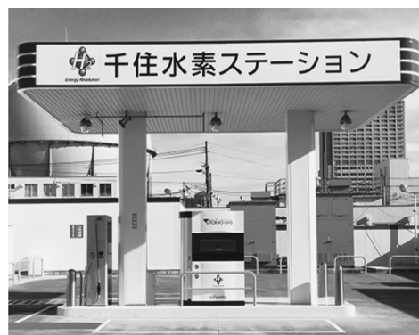
図7 水素ステーション適用例(東京ガス株式会社様ホームページより引用).
