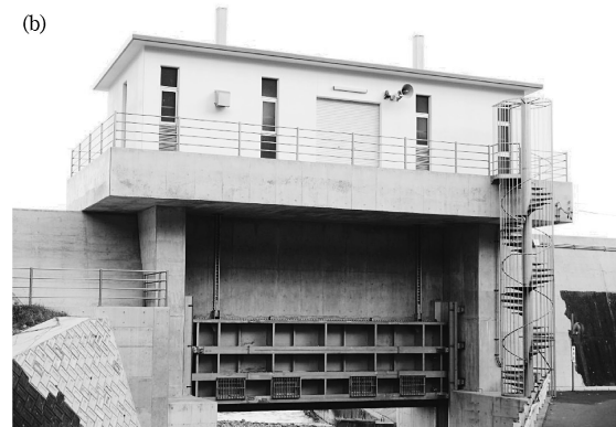
図3 NSSC®2120の適用例. (a) 二瀬ダム取水設備(埼玉県). (b) 小袖漁港水門(岩手県).
