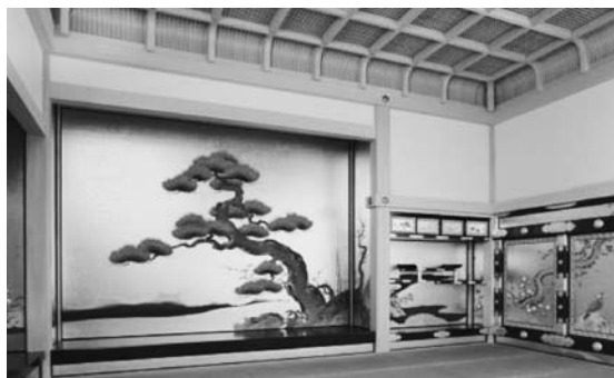
復元工事中の名古屋城本丸御殿。
