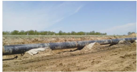
図8 APIグレード X60 鋼管の敷設状況.
