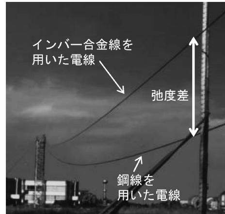
図8 インバー合金線と鋼線の垂下り例.
