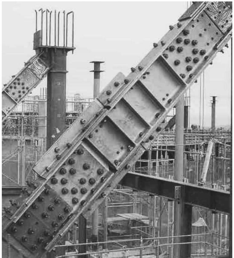
図4 軸力型制振ダンパーの概観。
